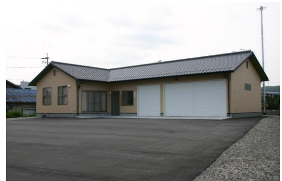
土岐津分団中核拠点施設
