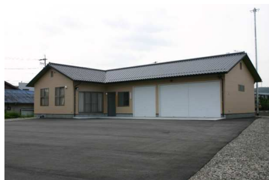
土岐津分団中核拠点施設
