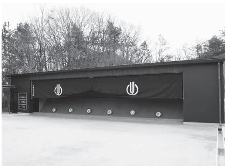
新設された弓道場
