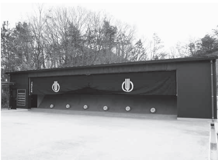
新設された弓道場
