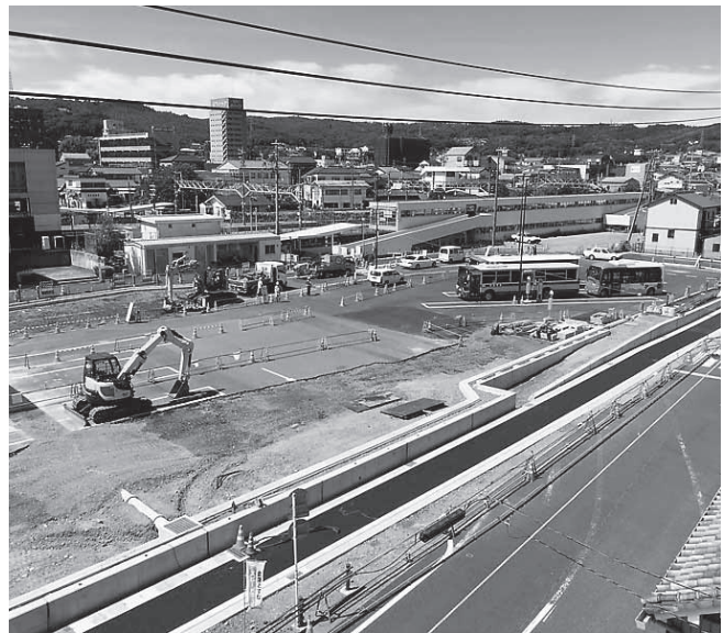
整備中の駅前広場
