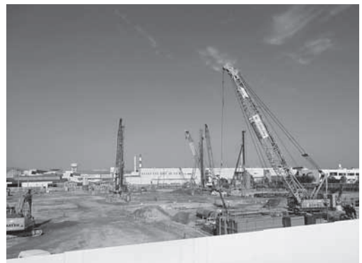
△高砂市の建設中のごみ処理施設
