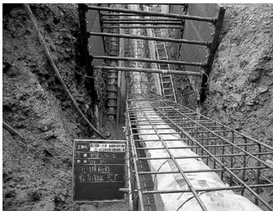
▲整備が進む緊急時連絡管図
