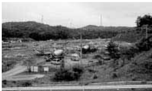
整備中の土岐PA
