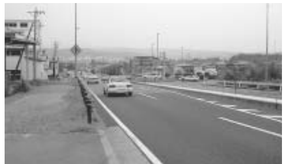
中央道土岐IC出口
