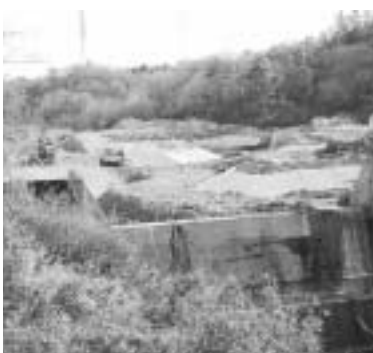
追沢川工事現場
