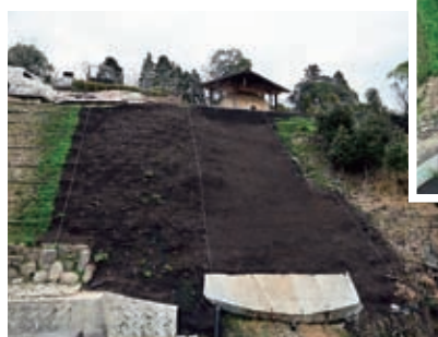
復旧工事完了後の崖地
