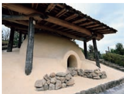
補修完了後の復元窯（東1号窯）
