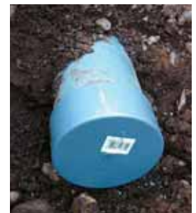
▲取付管にキャップをして閉栓
