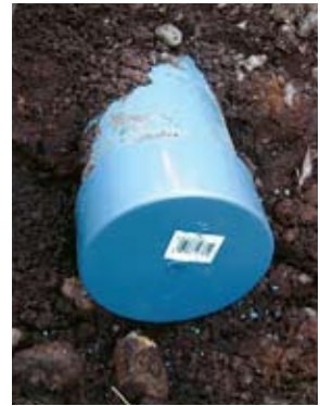
▲取付管にキャップをして閉栓
