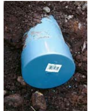
▲取付管にキャップをして閉栓
