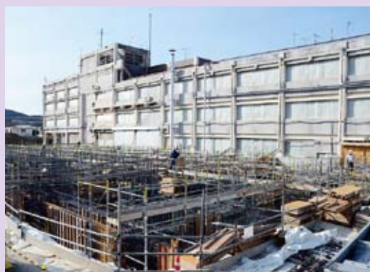
▲新庁舎建設中の現場
