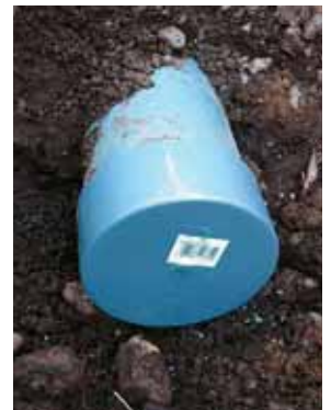
▲取付管にキャップをして閉栓
