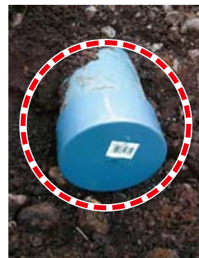
▲取付管にキャップをして閉栓
