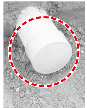
▲取付管にキャップをして閉栓
