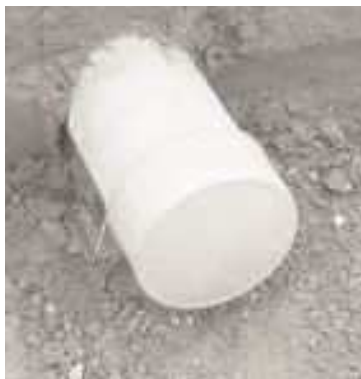
▲取付管にキャップをして閉栓
