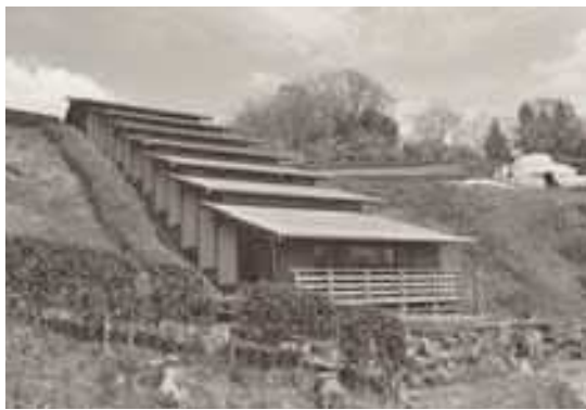
元屋敷窯（連房式登窯） 美濃地域最古の連房式登窯です。1958年に発掘されたもので、現在も当時の姿を留めています。
