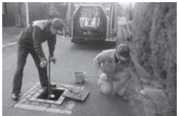
▲水利点検の様子
