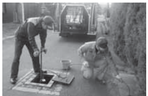
▲水利点検の様子
