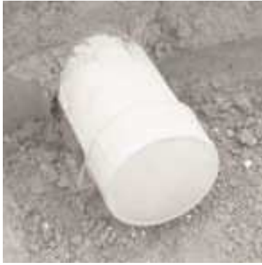
▲取り付け管にキャップをして閉栓
