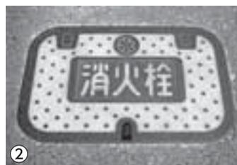
は地面下に設置された「地下式消火栓」です。地下式消火栓は、蓋が丸や四角の形をしたもの(写真②)、絵が描いてあるもの(写真③)があり、市内各地に設置されています。
