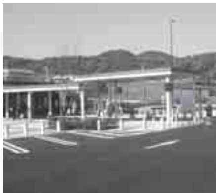
▲五斗蒔パーキングエリア(内回り)
