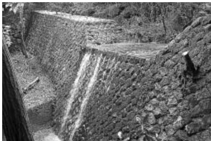
えんてい 浦山第2砂防堰堤(国登録文化財)
