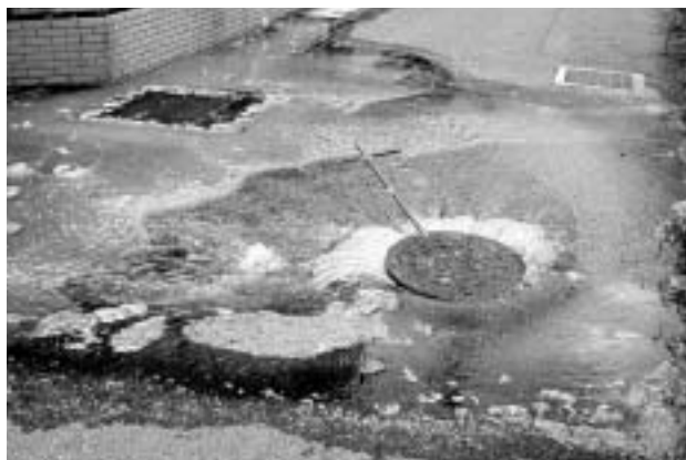
汚水があふれ出ている様子
