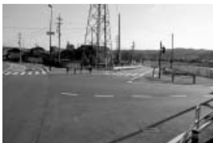
永久橋取り付け道路
