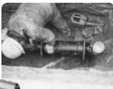
耐震管の施工
