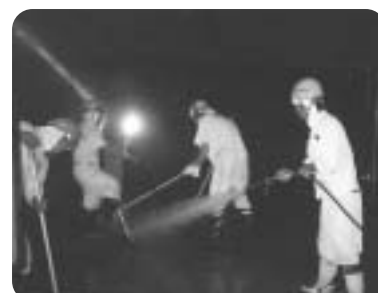
配水タンクの内部清掃
