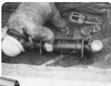
耐震管の施工
