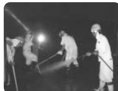
配水タンクの内部清掃
