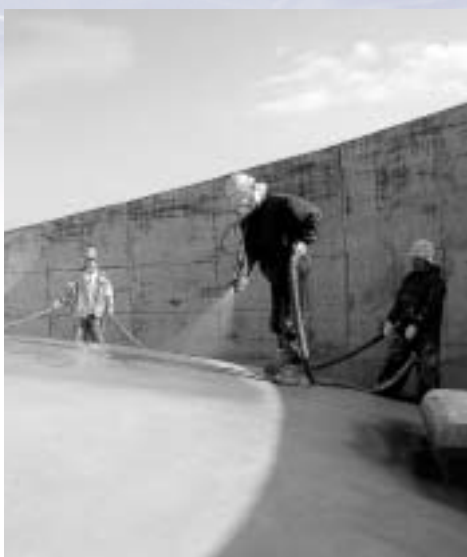
配水タンクの屋根補修
