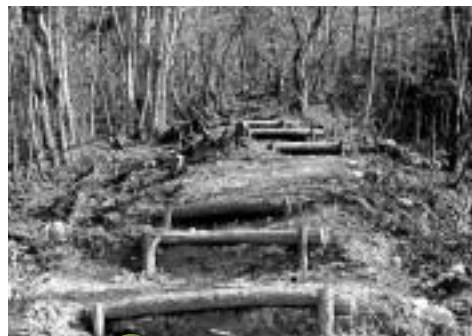
C 新設された歩道
