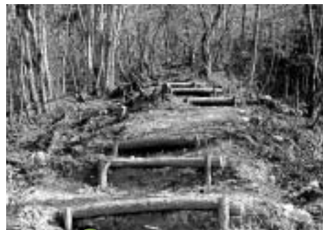
C 新設された歩道
