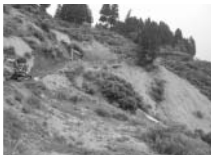
道路工事の様子
