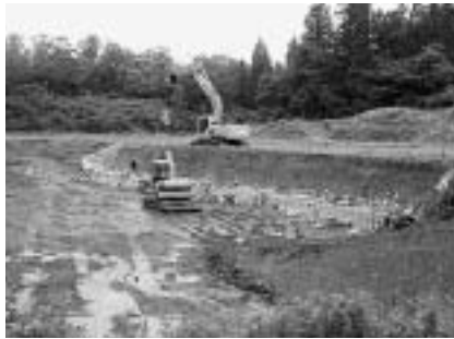
農地工事現場の様子
