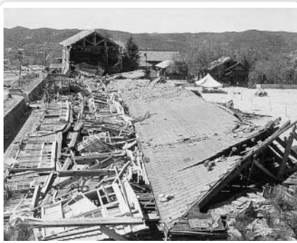
下石小学校が倒壊するなど市内の被害額は14億6千万円に上りました。 (写真は倒壊した下石小学校)
