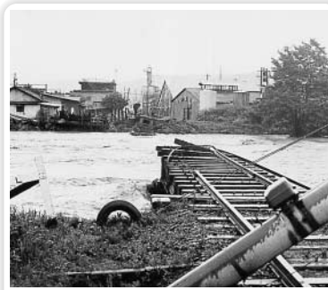
鉄橋は復旧されことなく2年後に廃線となりました。
