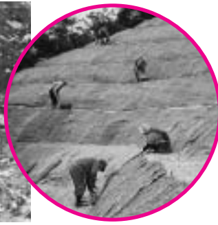
▲ 治山工事の様子
