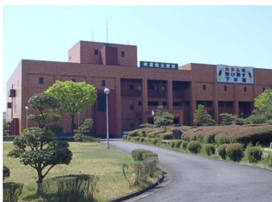
図 3-1 土岐市浄化センター
