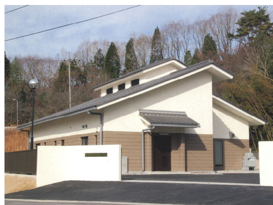
図 3-2 土岐市柿野浄化センター
