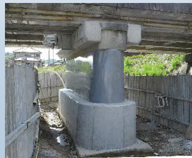
耐震補強工事実施状況
