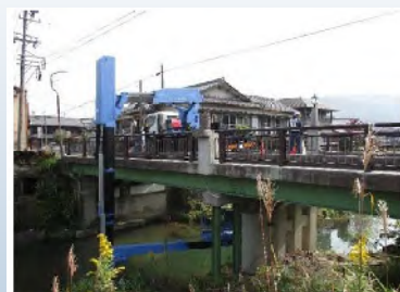
点検実施状況
