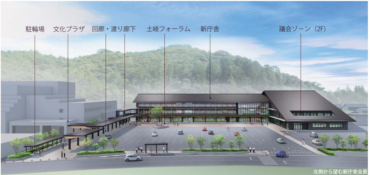
北側から望む新庁舎全景
