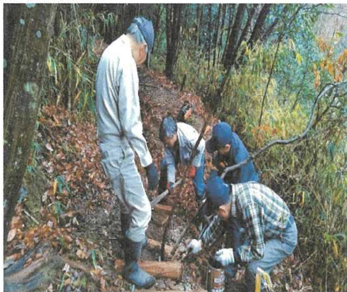
遊歩道階段整備
