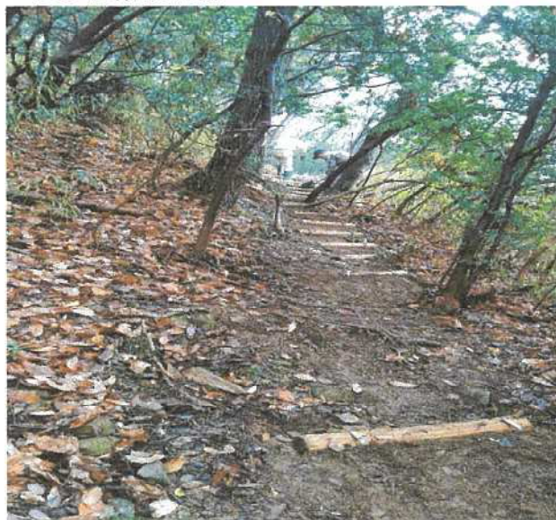
遊歩道階段整備
