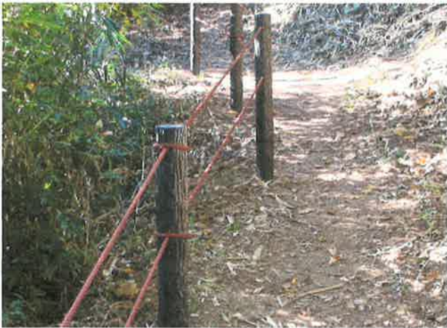
上下2本のロープで固定 下側のロープにスズラン灯を取り付ける予定
