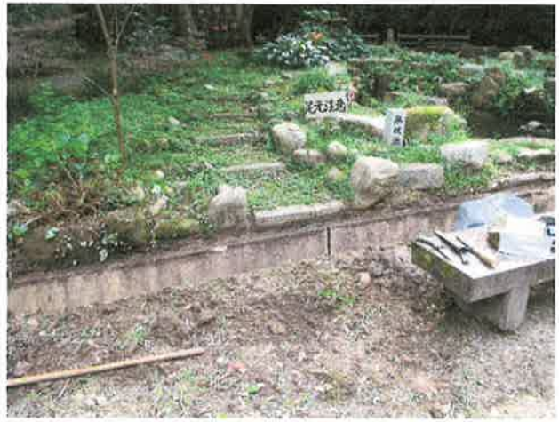
木製の蓋を取り外して溝掃除
