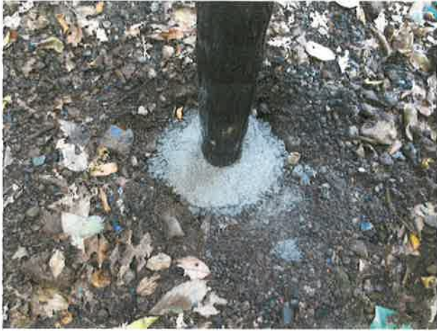
約40cm埋設しコンクリートで固める。
