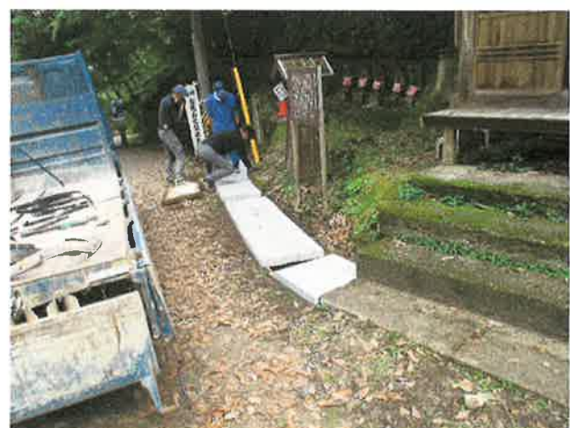
全部で42枚施工
