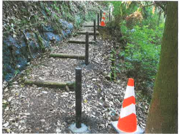
2m間隔で杭を立てる。
