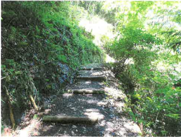
穴弘法からの登り口 施工前
