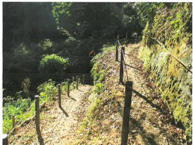
危険箇所 施工後
