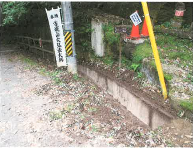
木製の蓋を取り外して溝掃除
