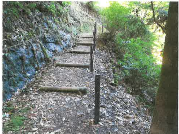
穴弘法からの登り口 施工後
