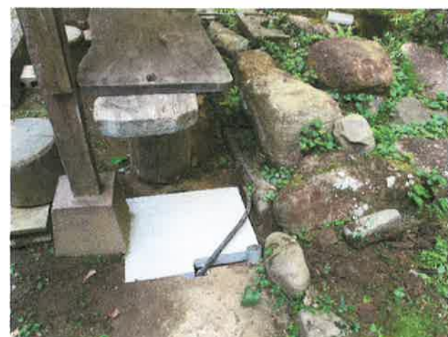
本堂前 施工後
