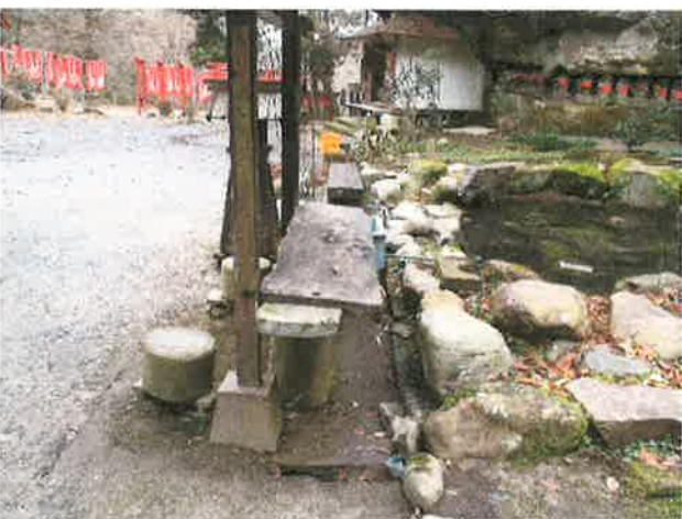
本堂前 施工前
