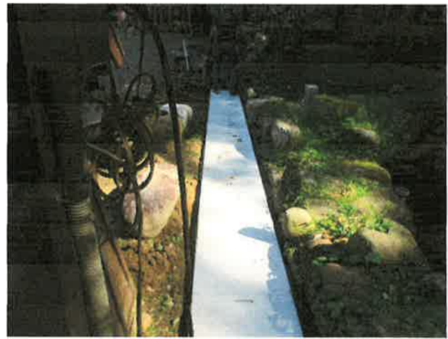
定型のコンクリート蓋取付 ガタツク所にはゴム板で修正
