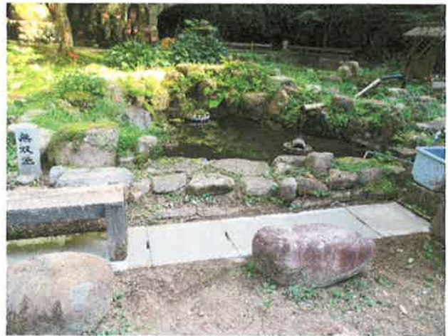
無双池の前 施工後
