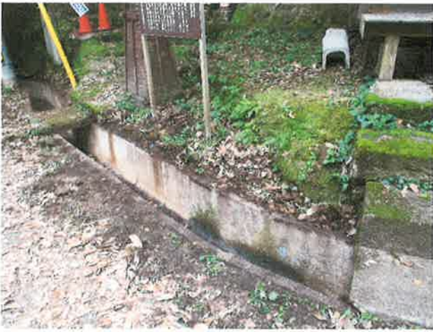
木製の蓋を取り外して溝掃除
