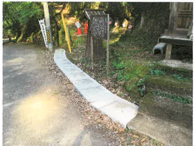
子守り地蔵堂の前 施工後
