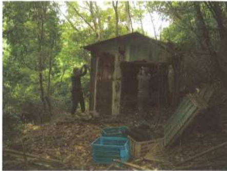
廃屋取り壊し
