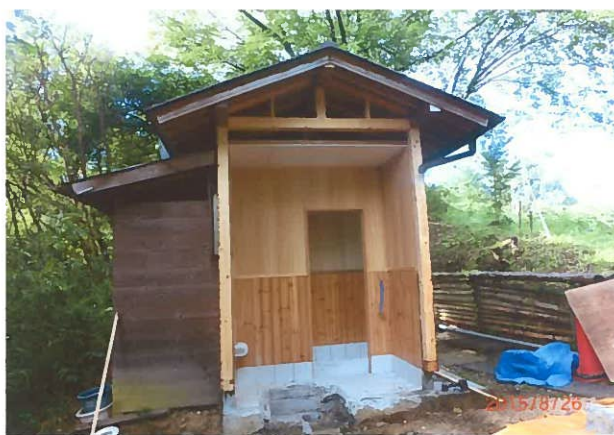
改修中(壁取壊し)
