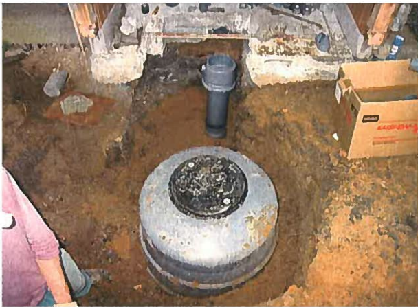
改修中（便槽設置）
