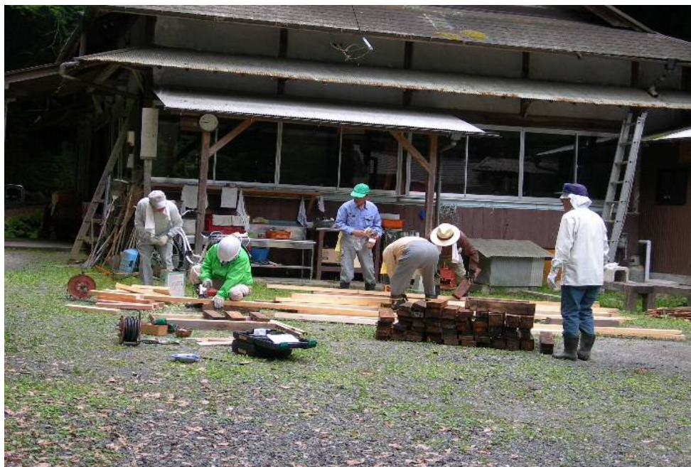
側溝板の切断・防腐剤塗布
