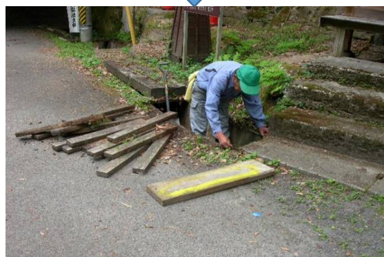
古い側溝板の除去
