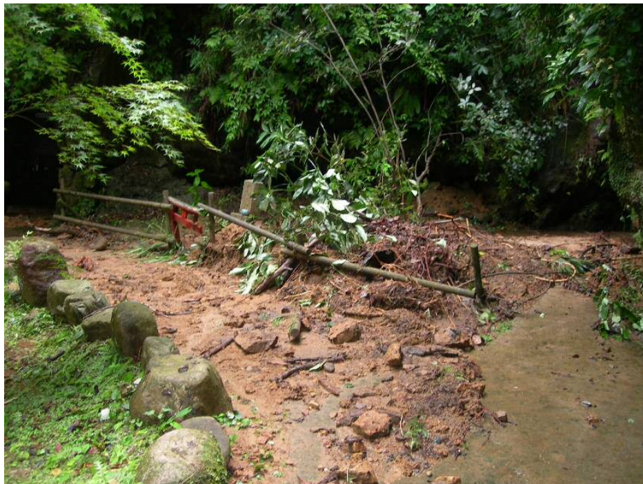
滝壺に堆積した土砂(大型ダンプ2台分?) この土砂の除去は土岐市が実施
