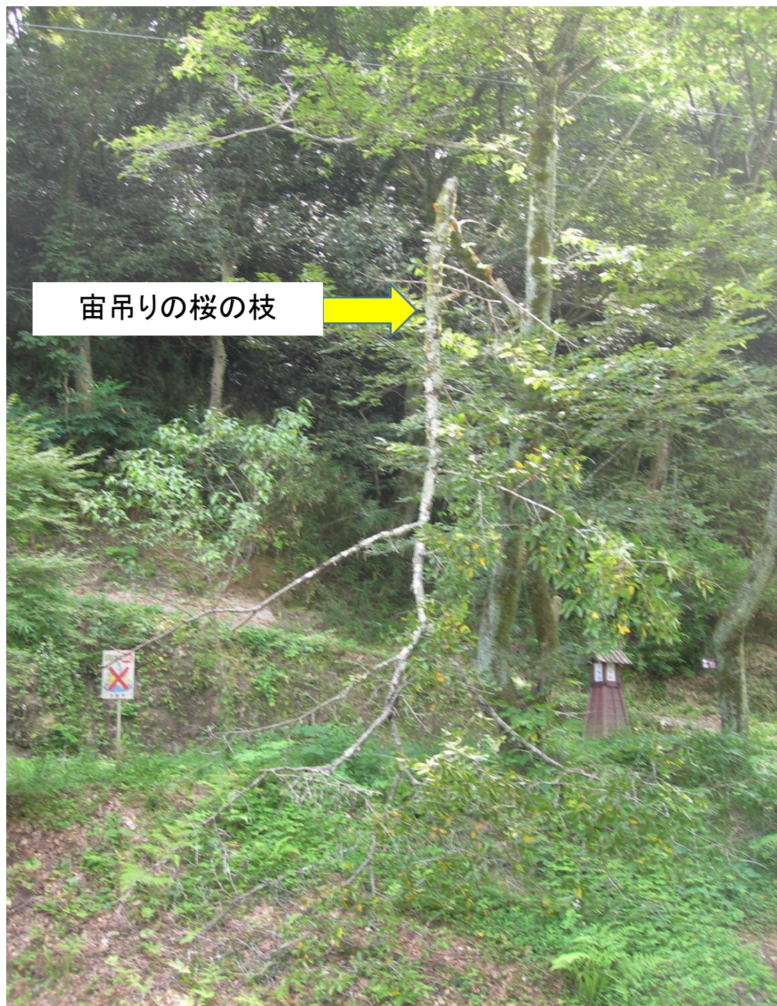
宙吊り状態の折れた桜の枝(直径約25cm)(H29年8月2日)。駐車場のり面
