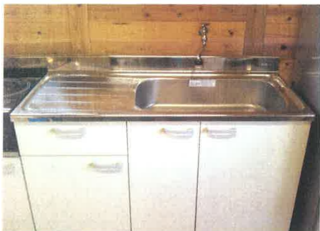
センターハウス 内側（蛇口付近）
