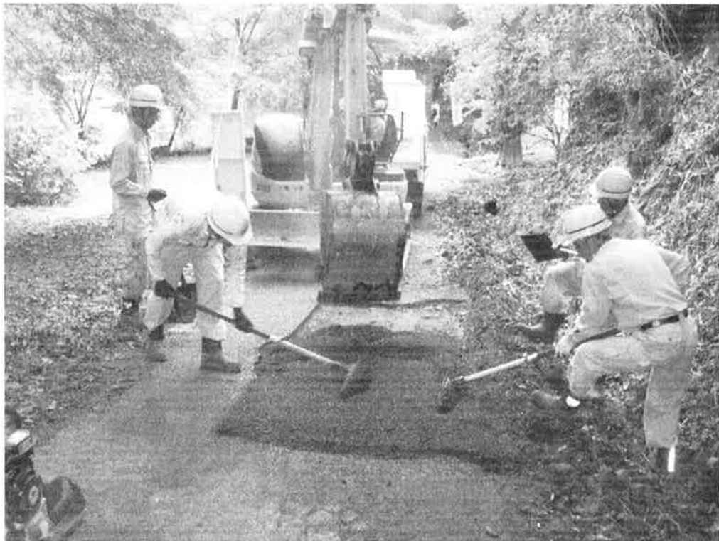
アスファルト舗装作業
