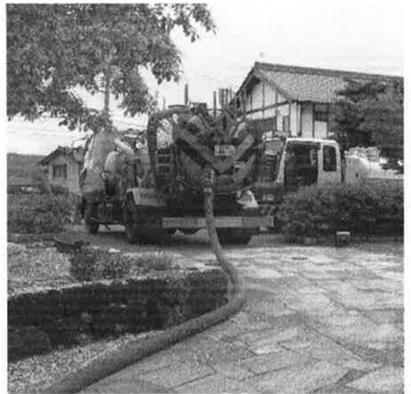
バキューム車で泥を吸引
