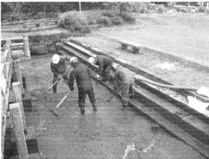
業者による泥の掻き出し作業
