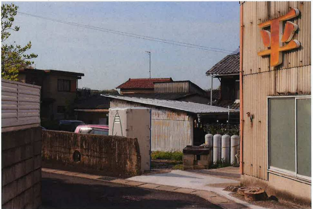
トイレ施工後
