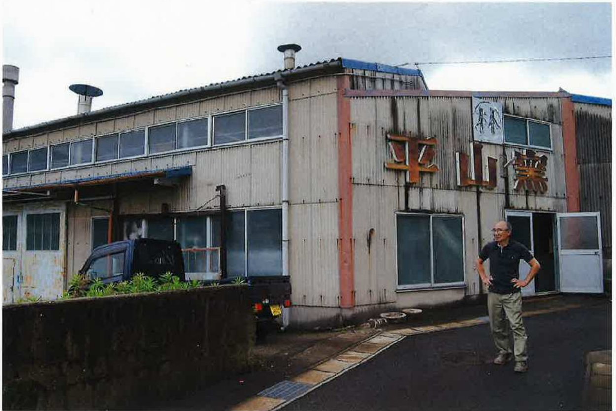
トイレ施工前
