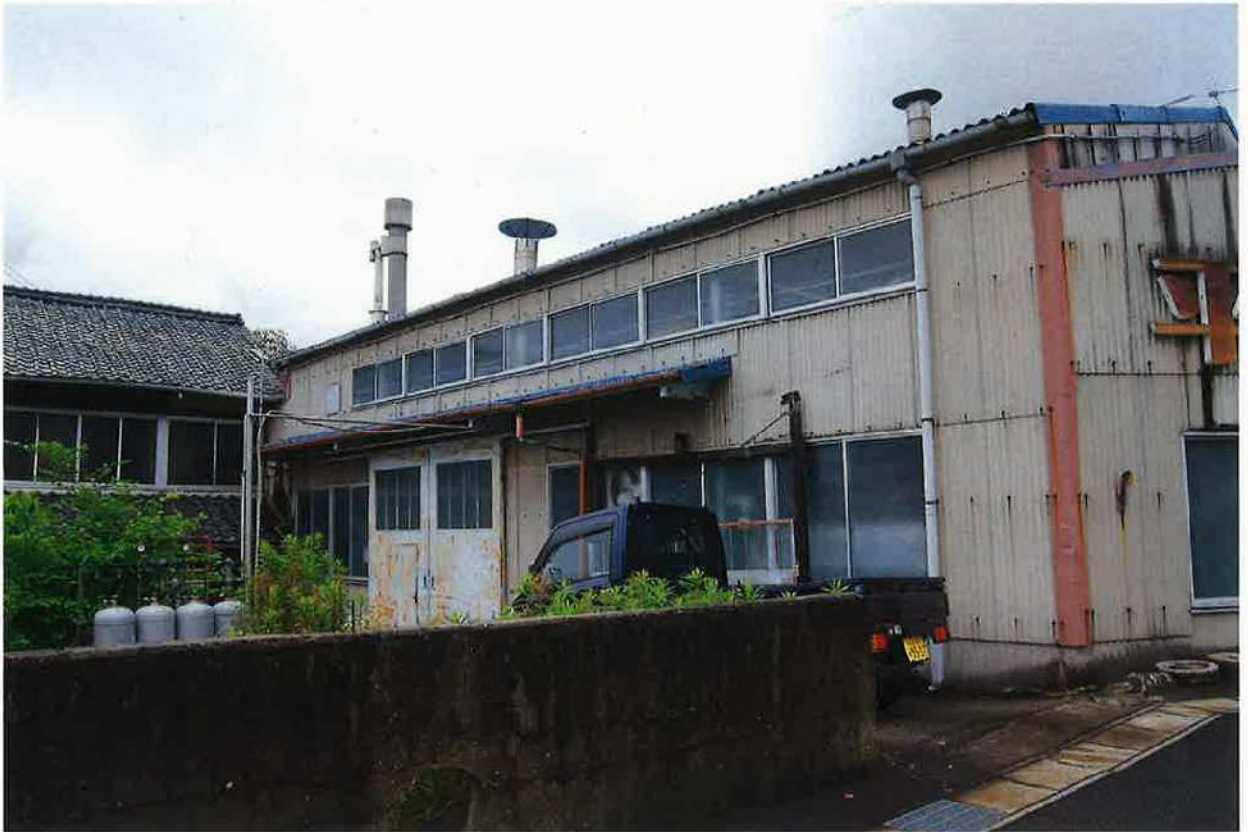
トイレ施工前
