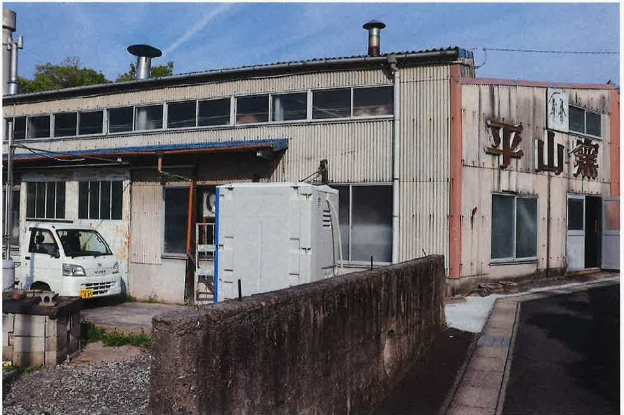
トイレ施工後
