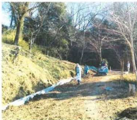
排水溝設置作業
