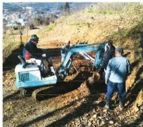
排水溝設置作業
