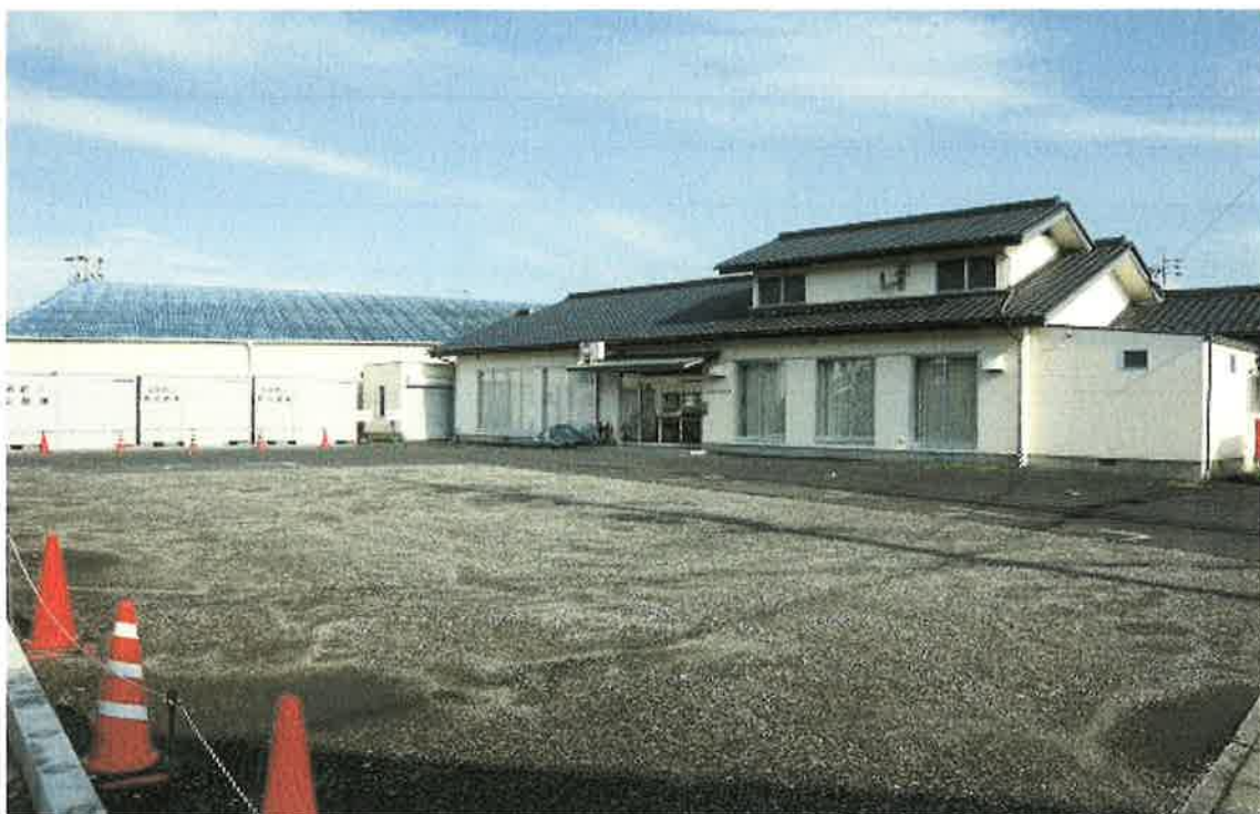
令和3年7月 着工前
