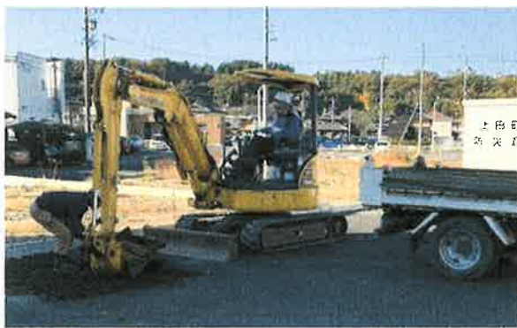
11月 旧舗装全面剥がし (費用別途町内会負担にて)
