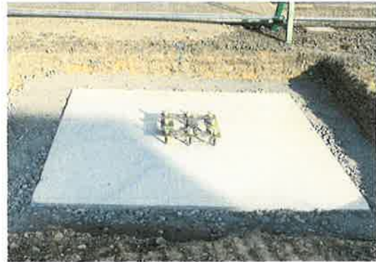
基礎完成 (2.1m角×3.65m深 6基)
