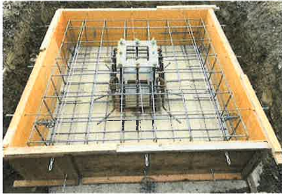
基礎工事 (鉄筋組み)
