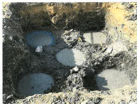
基礎工事 (柱状改良)
