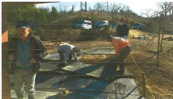
東屋前のゴムマット設置作業
