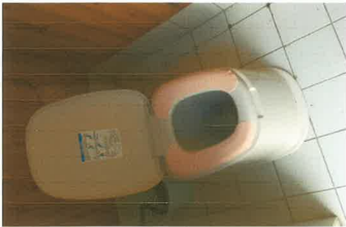
和式トイレに洋式便座を設置
